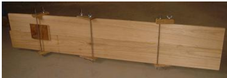
Figura 4. Pranchas em freijó sendo coladas.
